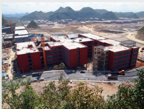
花溪校区施工现场
