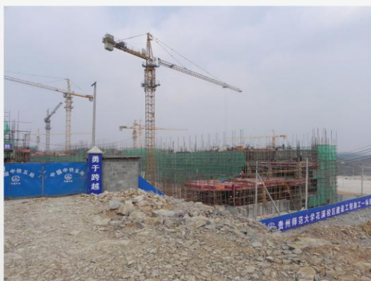
花溪校区施工现场
